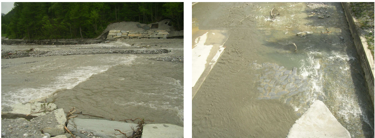
Figura 5 – Anno 2009. Condizioni di torbidità della portata di morbida in ingresso al bacino. Effetto di diluizione delle portate rilasciate a valle diga ad opera del by-pass (vaso in condizioni di portata in ingresso non torbida).
