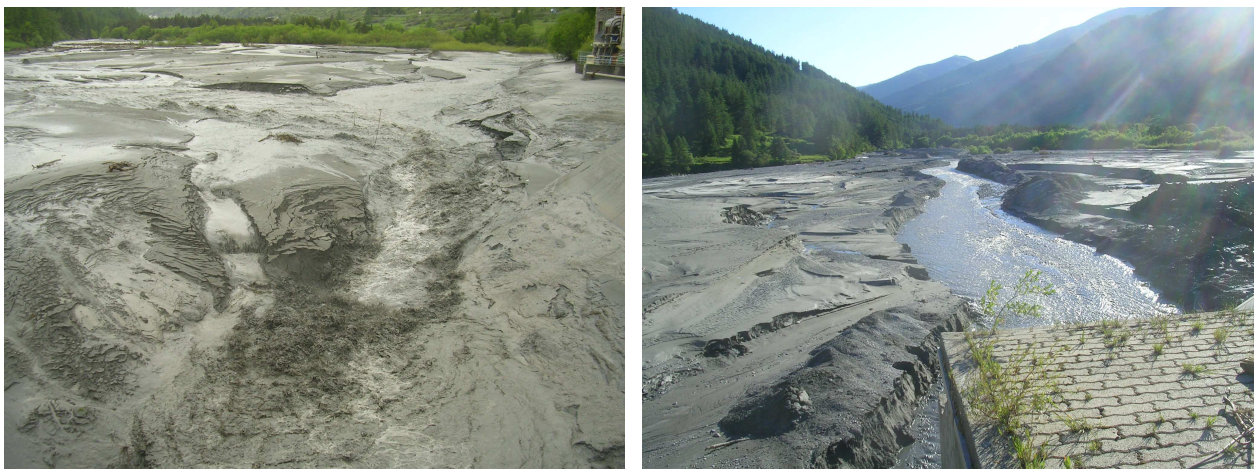
Figura 1 – Anno 2008. Condizioni del bacino a seguito dell'evento di piena di maggio (sx); condizioni del bacino con alveo primario ricostituito a seguito delle manovre eseguite (dx).
