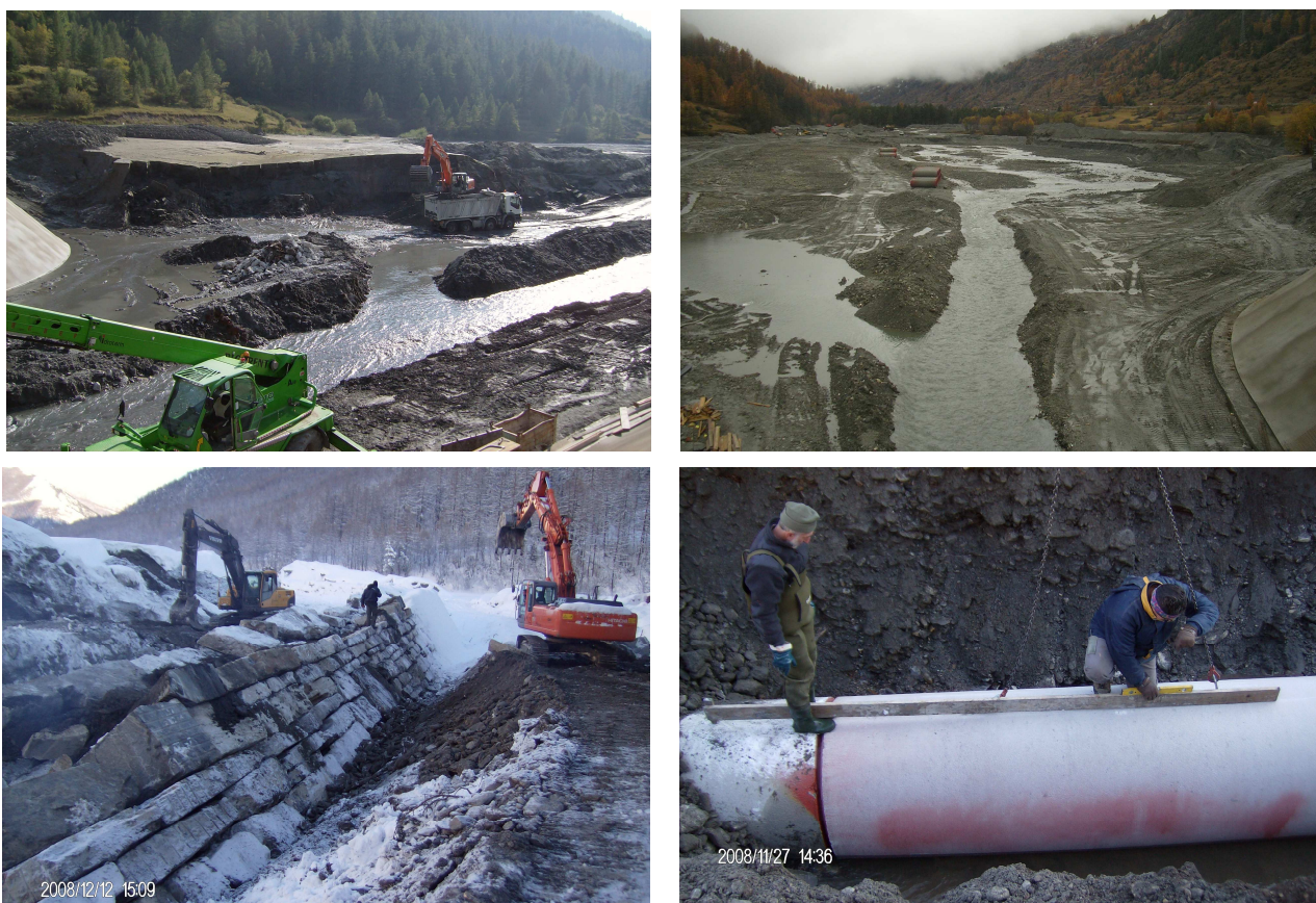
Figura 4 – Anno 2008. Rimozione dei depositi sabbioso-limosi nella porzione di valle dell'invaso e ricollocazione nell'area sistemata a incile bacino. Realizzazione scogliera di protezione di monte e canale di by-pass.
